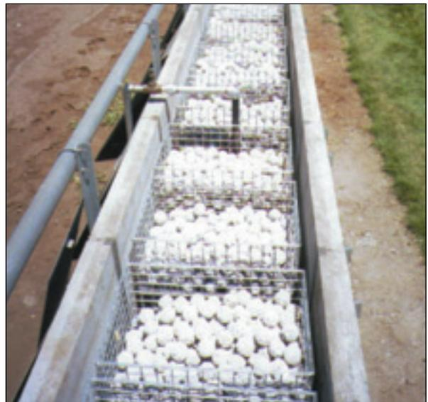
図2 紙の廃棄物の焼却灰より合成したゼオライトを、エコボールと称するボール状に成型して、これを水路に置いて水質浄化をしている写真。
